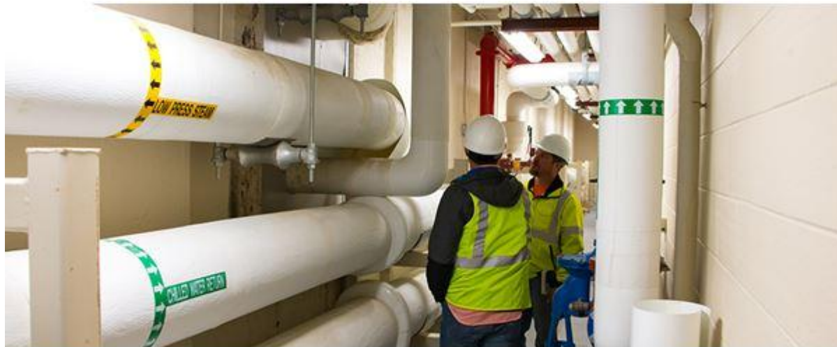
Рисунок 26. Цокольный этаж казармы Дэвиса
