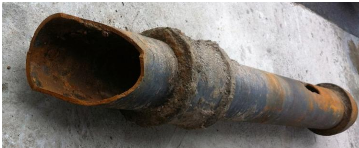
Рис.7 Труба Ду 250 мм английского производства прокладки 1890 г.
