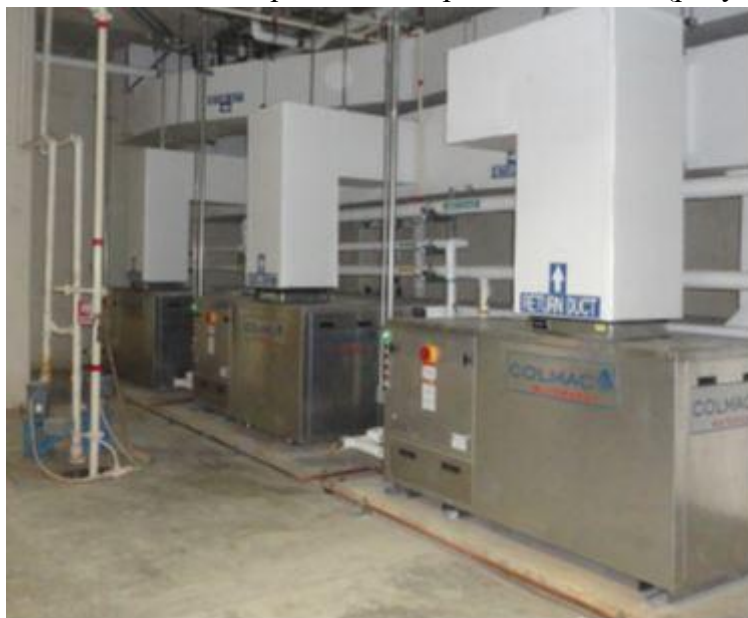
Рис. 3. Новые тепловые насосы
