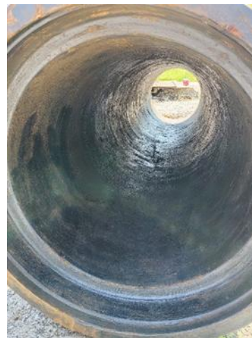
Рис. 3 Чугунная водопроводная труба Ду 800 мм (после удаления грунта металлической щеткой) прокладки 1900 г., извлеченная в 2025 г. при реконструкции водовода на Васильевском острове, после 125 лет безаварийной эксплуатации.
