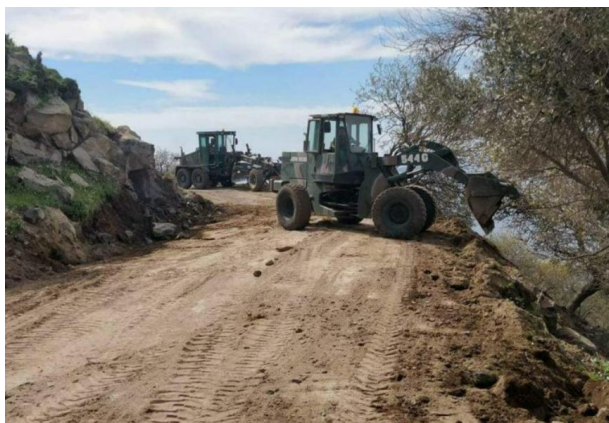
Рисунок 6. Прокладка новой дороги
