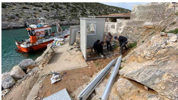
Рисунок 7. Подразделение Отдела проектирования и строительства в ходе ремонта и модернизации каменного дома
