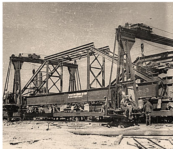
Рис. 10 - Изготовление шпренгельных пролётов
