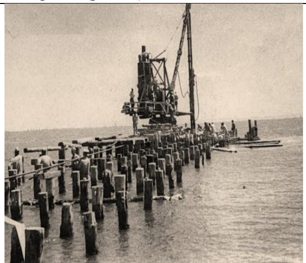
Рис 12 - Забивка свай на эстакаде
