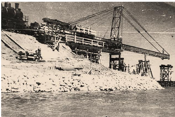
Рис. 11 - Надвижка краном-пилоном первого шпренгельного пролётного строения
