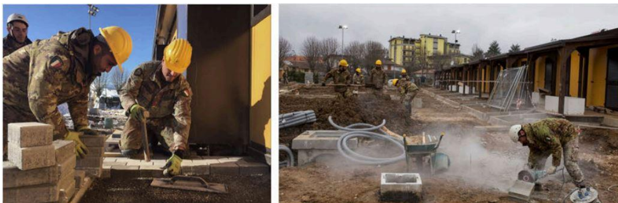
Рисунок 3. Личный состав 6-го инженерно-саперного полка в ходе выполнения строительно-монтажных работ
