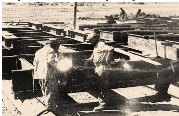
Рис. 7 - Изготовление металлических ростверков
