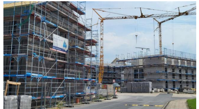
Рис. 5. Строительство в г. Унна восьми новых казарм для 1300 военнослужащих
