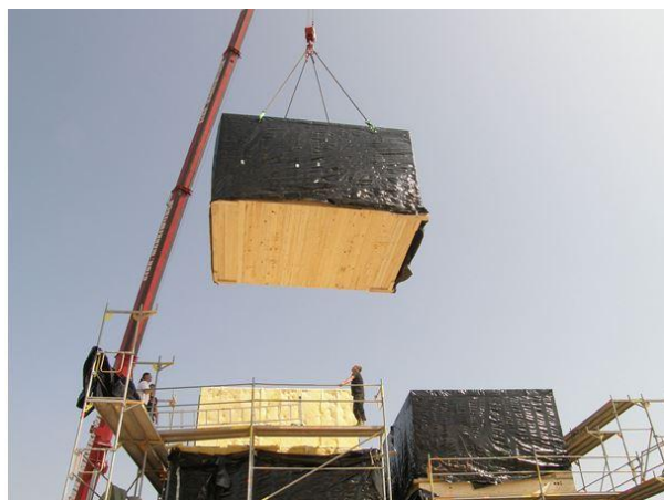
Рисунок 8. Строительство модульного здания
