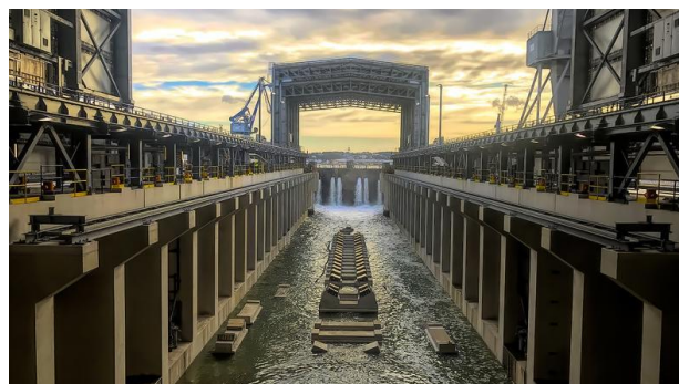
Рис. 9. Построенные технические сооружения для атомных ударных подводных лодок проекта «Барракуда»
