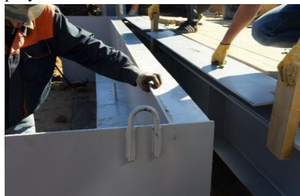
Рис. 5 – монтаж шкафной стенки моста «Тайпан»
