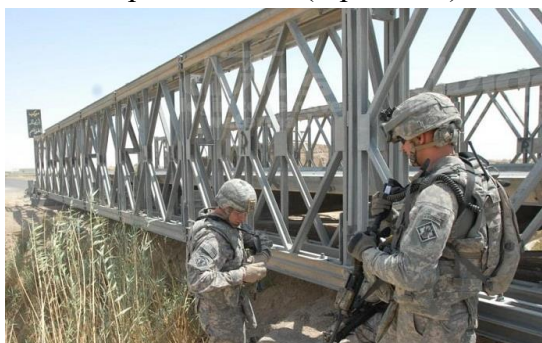
Рис. 2 – Мост Бейли на подъезде к военной базе США в Сирии 2020 г.
