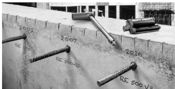
Фото.3. Крепление металлооблицовки с помощью химических анкеров
