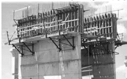
Фото. 3. Восстановление поврежденных участков ТЗП путем применения скользящих опалубок
