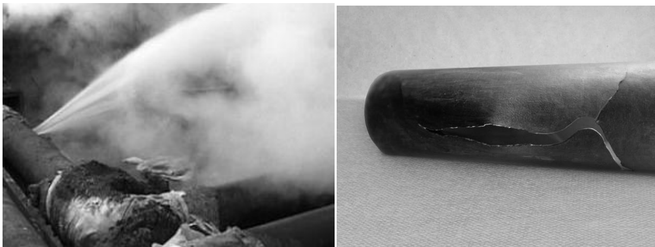
Рис. 2 Разрушение металлических трубопроводов ударным давлением
