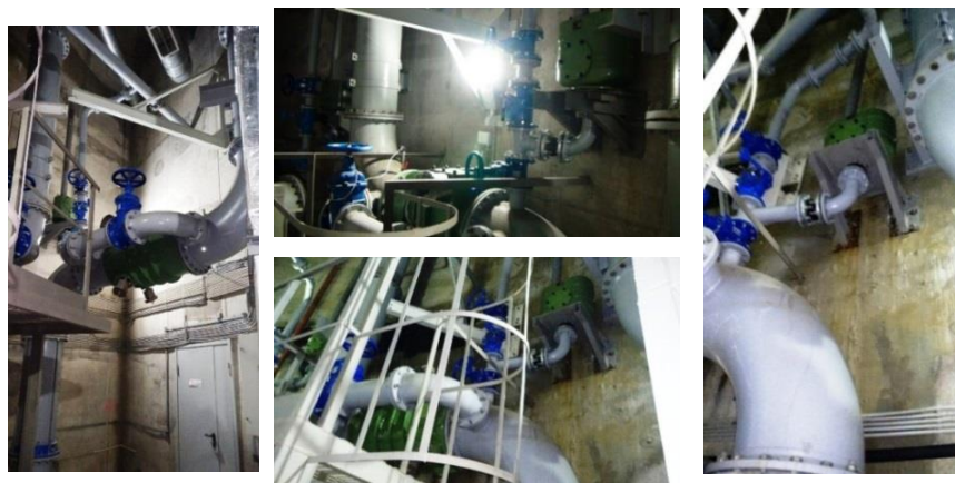
Рис. 1. Общий вид защитного оборудования УРС-422: а) обратный клапан D_y=400 мм;
