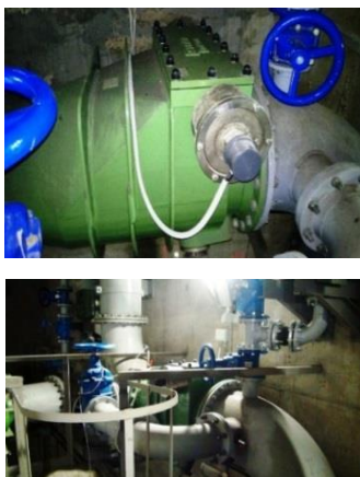
Рис. 1. Общий вид защитного оборудования УРС-422: а) обратный клапан D_y=400 мм;
