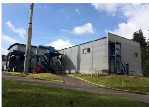
Общий вид теплоэнергетического комплекса п. Приветнинское, Ленинградской обл.
