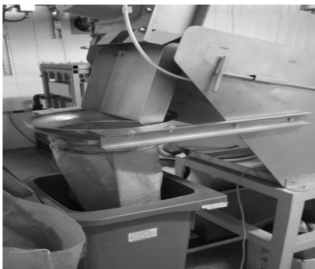
Рис. 5. Фильтрующий мешок для дополнительного обезвоживания, хранения и транспортировки обезвоженного осадка.
