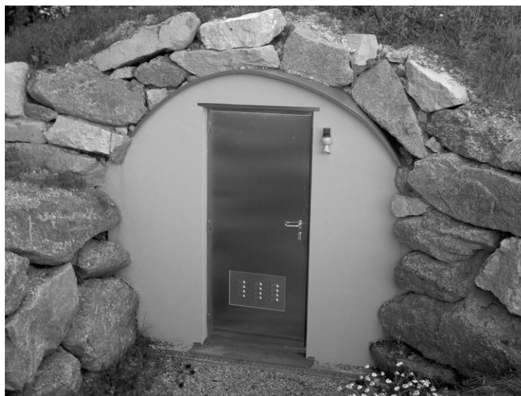
Рис.10. Общий вид размещения резервуара с обваловкой грунтом.
