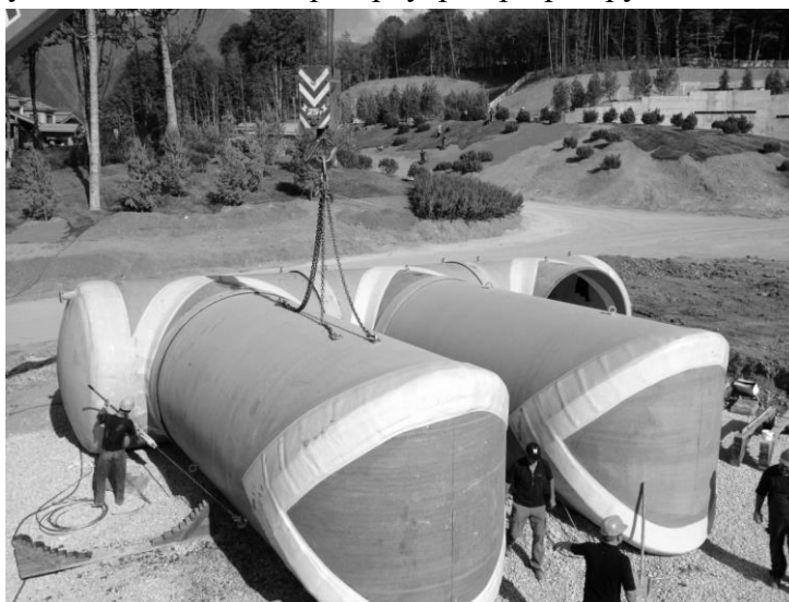
Рис.4. Общий вид резервуара в процессе монтажа.
