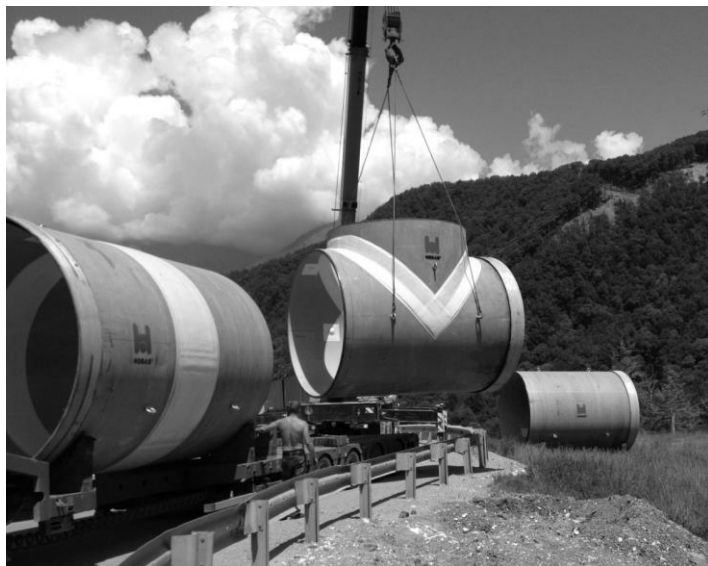
Рис.3. Конструктивные элементы резервуара при разгрузке на площадке.
