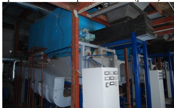
Рис.6. Котлоагрегат с топкой высокотемпературного кипящего слоя КВП 1.74 ВТКС
