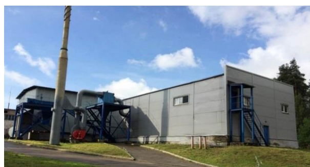
Рис.6. Общий вид комплекса п. Приветнинское Ленинградская обл.
