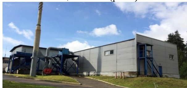
Рис.5. Общий вид комплекса п. Приветнинское Ленинградская обл.
