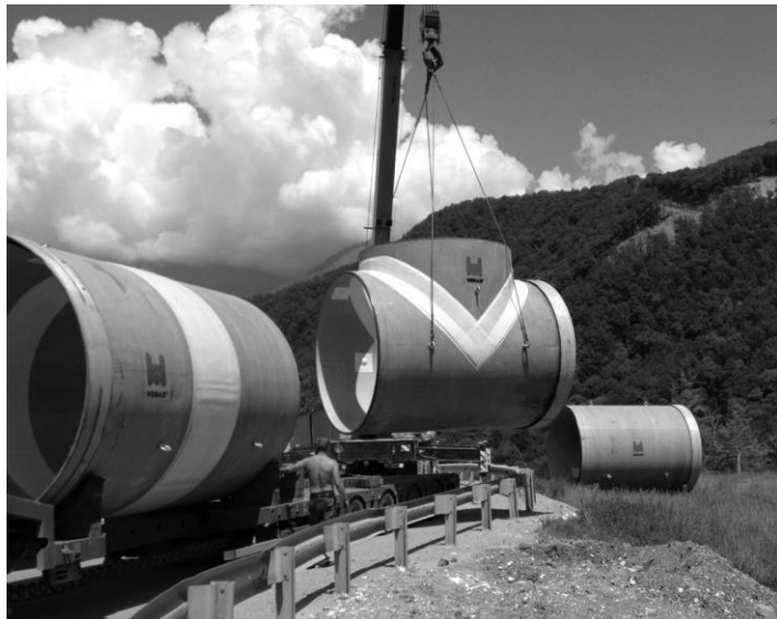
Рис.3. Конструктивные элементы резервуара при разгрузке на площадке.
