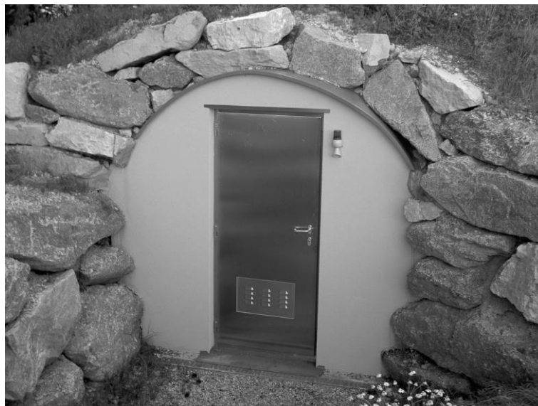
Рис.10. Общий вид размещения резервуара с обваловкой грунтом.
