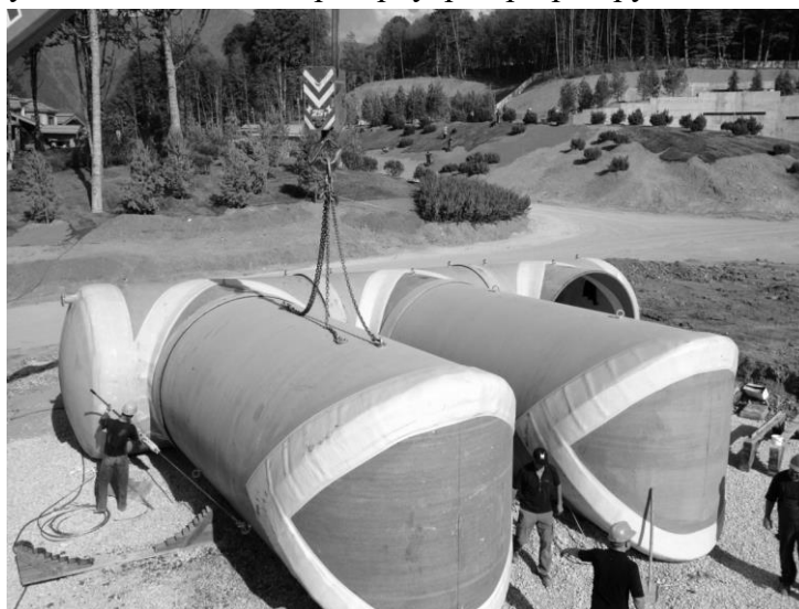
Рис.4. Общий вид резервуара в процессе монтажа.
