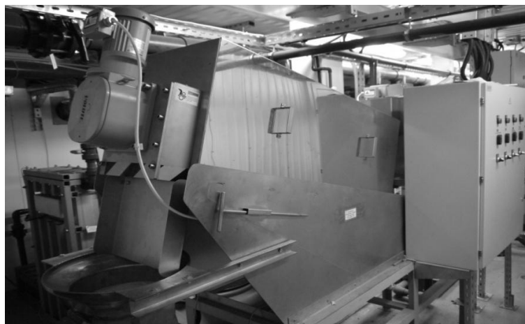
Рис. 2. Шнековый обезвоживатель ES201
