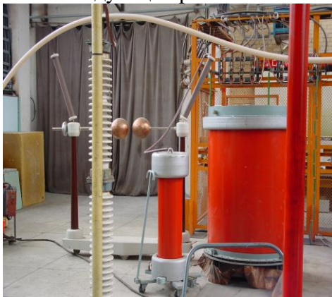
Рис.2. Испытание оборудования и средств защиты на стойкость к воздействию ЭМИ.
