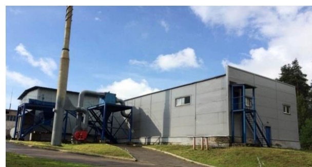
Рис.6. Общий вид комплекса п. Приветнинское Ленинградская обл.
