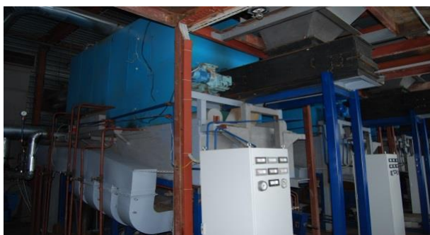
Рис.4. Котлоагрегат с топкой высокотемпературного кипящего слоя КВП 1.74 ВТКС
