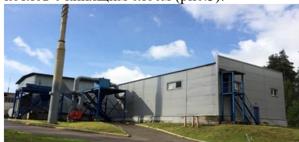
Рис.5. Общий вид комплекса п. Приветнинское Ленинградская обл.
